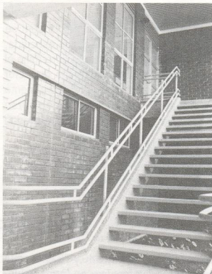
Aspecto exterior del Edificio de Física Experimental.
