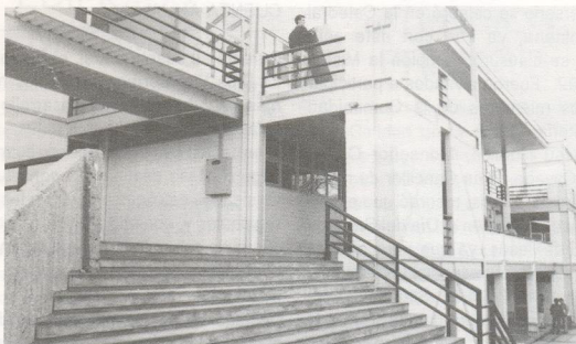
Un aspecto de la construcción que ahora alberga a la Escuela de Arquitectura.
